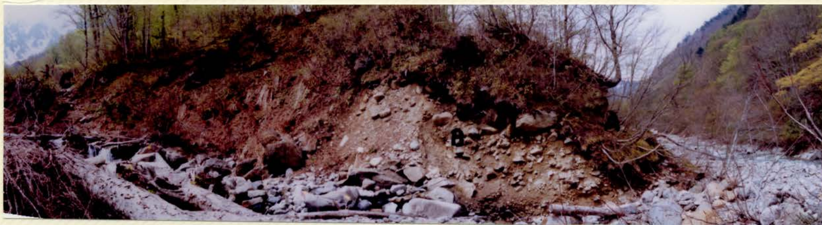
Fig. 4 崩れ去った夏道のあった崖、2001/6/19撮影。左岸の橋脚は無くなった。A：寮建設当時の夏道。 B：夏道のあた崖。 C：現在の道。
